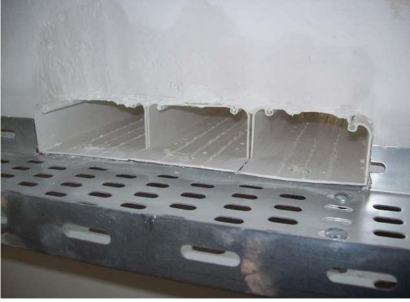
Sistem odası dış duvarı
